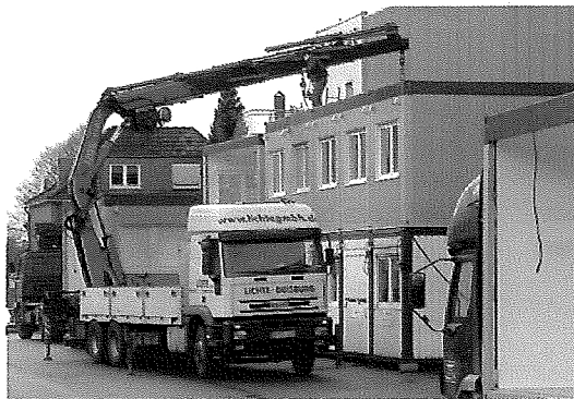
Know-how aus Duisburg: Aufstellung einer Lichte-Einheit
